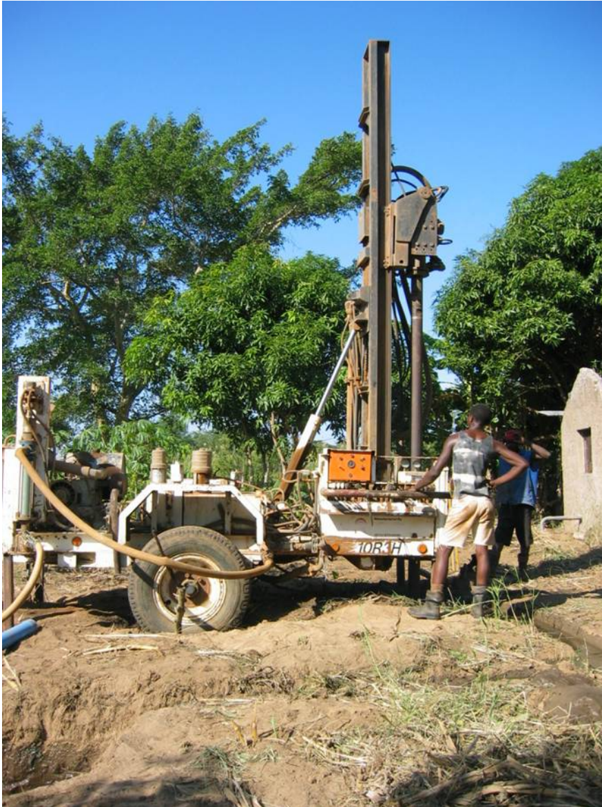
Brunnenbohrung in Mosambik (Foto: Helvetas)
